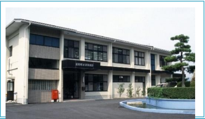
愛知県東海市行政組合水道事務所
